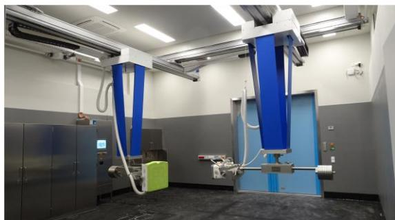
Der Röntgenarbeitsplatz verfügt über 2 Deckenstative mit bandgestützter Höhenverstellung. Beide können sowohl in Längs-als auch in der Höhenverfahung synchronisiert werden.
